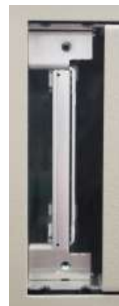
奥に突き当たるまで押し込み、蓋を取り付けます。
